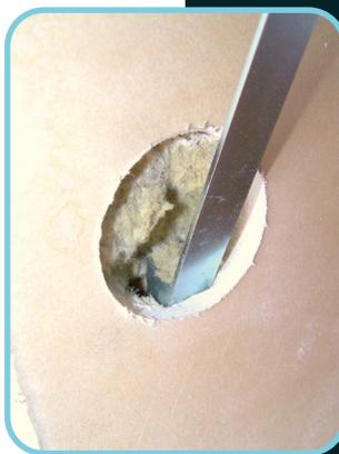
La forme biseautée de la canne permet de décoller la laine de roche du plâtre et assure une saignée le long de celle-ci. Son extraction évacue un peu d'isolant afin d'éviter les bourrages.
